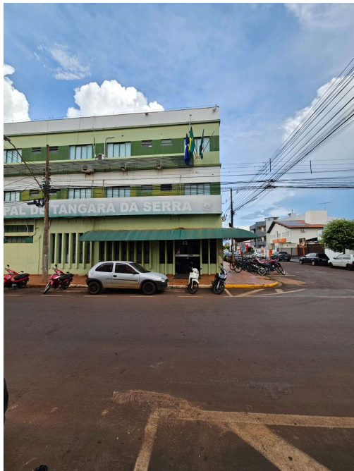
Figura 1: Fachada com desgaste visível
