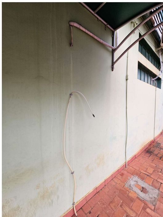
Figura 9: Dreno rompido
