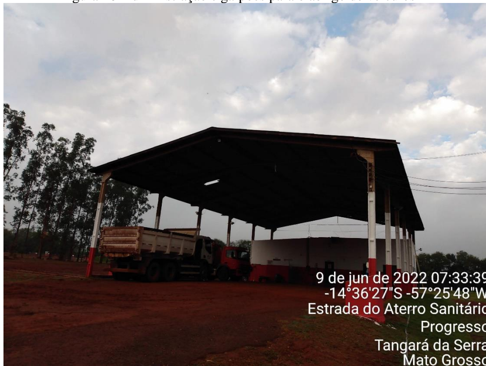
Figura 46-Administração e galpões para o abrigo de veículos
