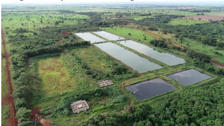
Figura 130-Estação de Tratamento de Esgoto - ETE Ararão.
