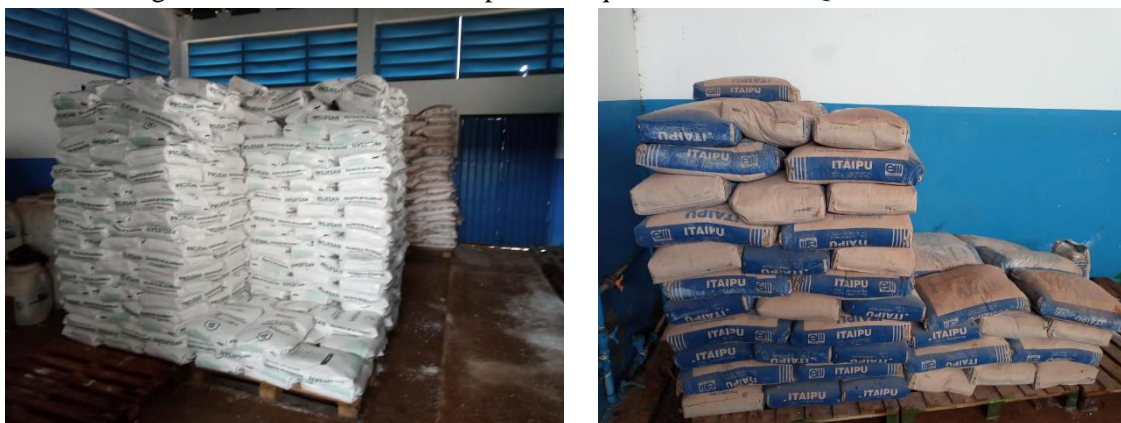
Figura 123-Almoxarifado dos produtos químicos da ETA Queima-Pé.
