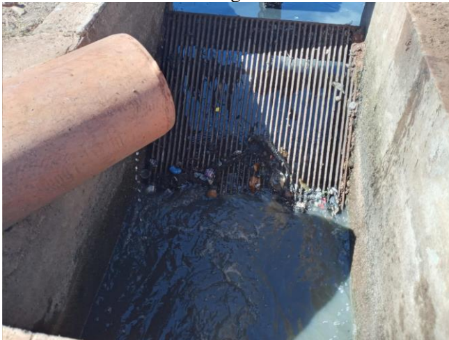
Figura 131-Resíduos sólidos retidos na gradeamento na ETE-Ararão.
