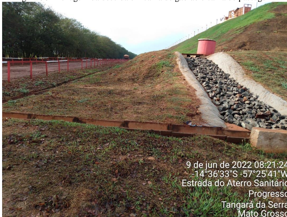
Figura 58-Drenagem da descida em calha de gabião e caixa de passagem.
