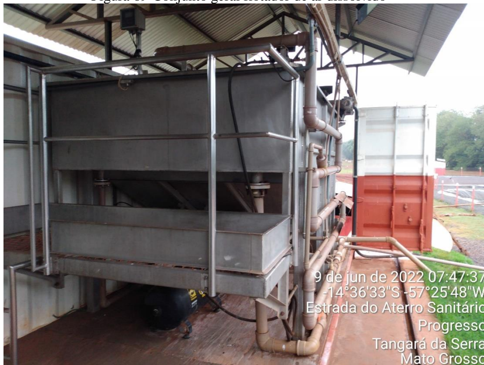
Figura 69-Conjunto geral flotor de ar dissolvido
