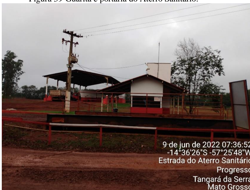
Figura 39-Guarita e portaria do Aterro Sanitário.
