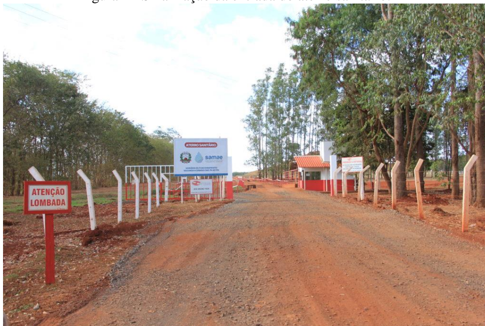
Figura 42-Sinalização da entrada do aterro sanitário.
