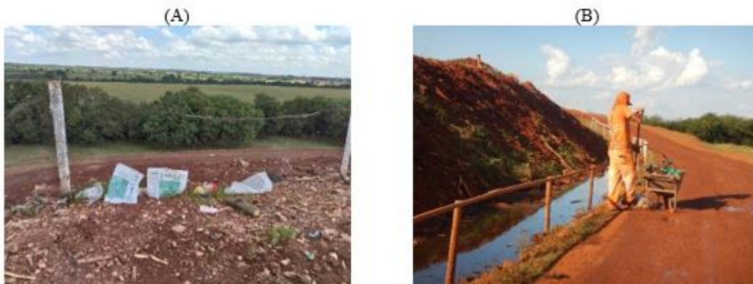
Figura 77-(A) Cerca de proteção, (B) Coleta de resíduos
