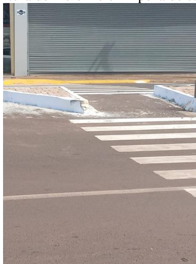
Figura 95-Pintura de meio-fio e limpeza de sarjeta.
