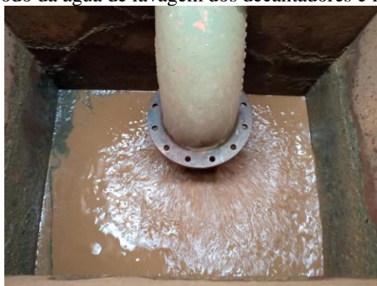
Figura 125-Lodo da água de lavagem dos decantadores e filtro.
