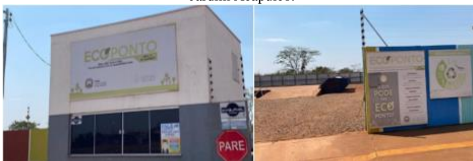
Figura 100-Ponto de coleta de Resíduos de Construção Civil e Demolição, localizado no Setor E – Jardim Acapulco.
