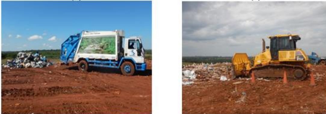
Figura 78-(A) Descarga de resíduos em pilhas, (B) Espalhamento e compactação de resíduos
