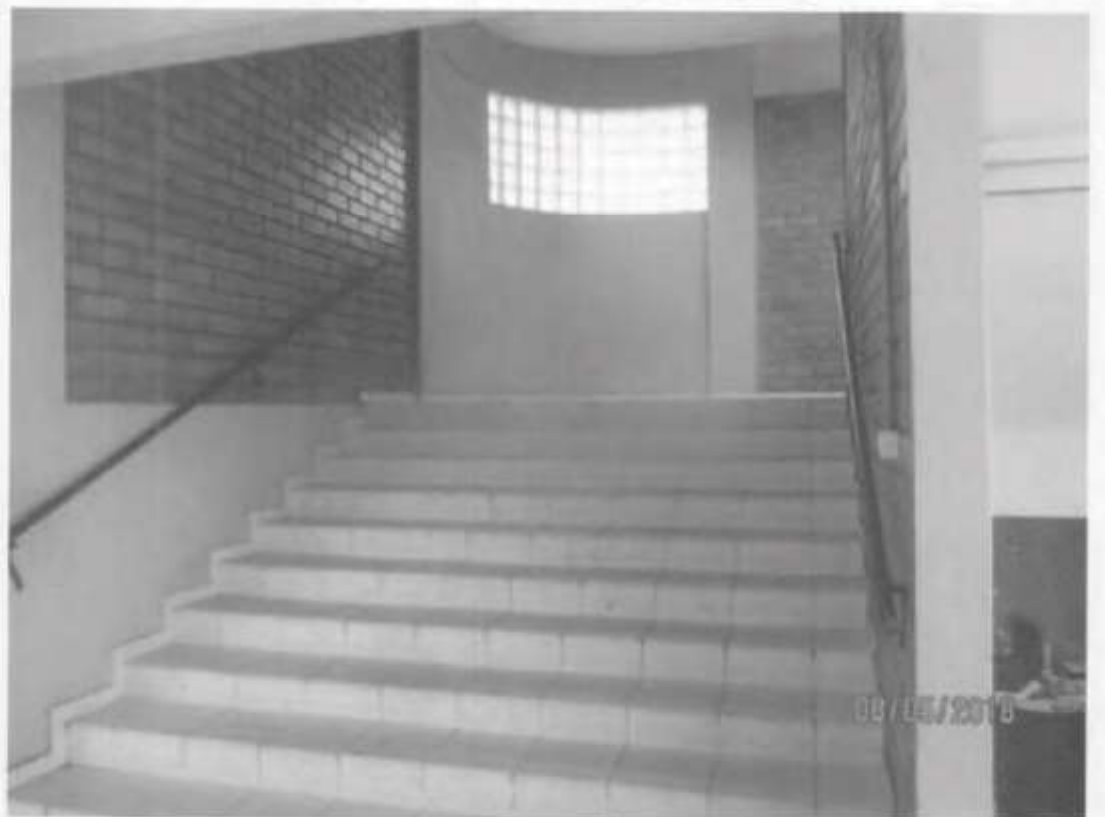
ESCADA DE ACESSO
