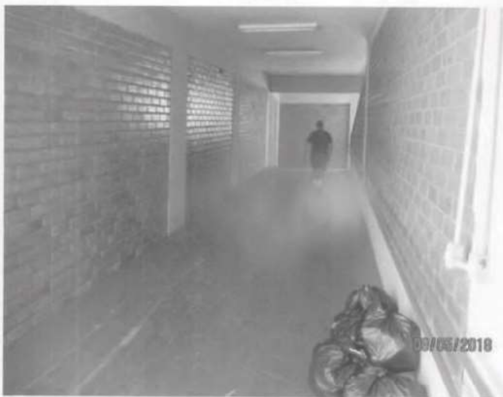
RAMPA DE ACESSO
