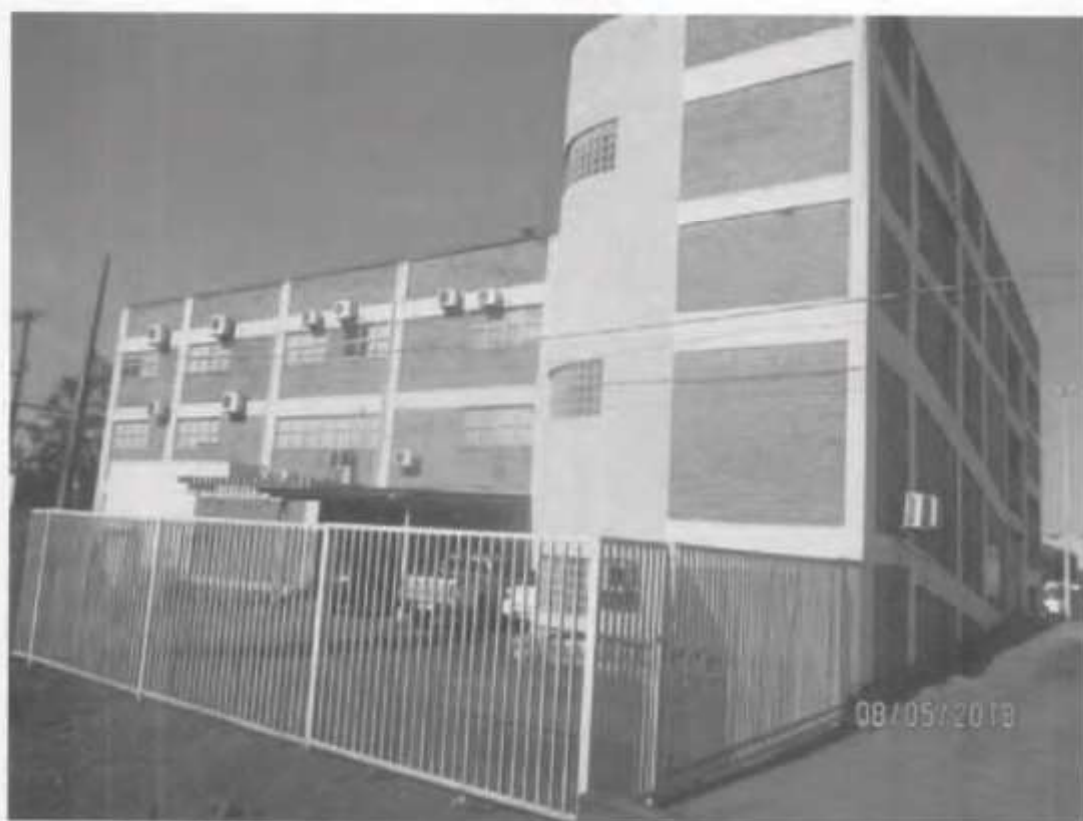
BLOCO A AOS FUNDOS
